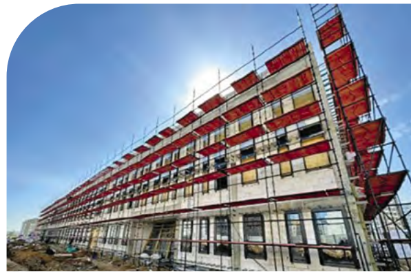
В СОШ на 1500 мест в ЖК «Ильинские луга» ведется устройство фасада
